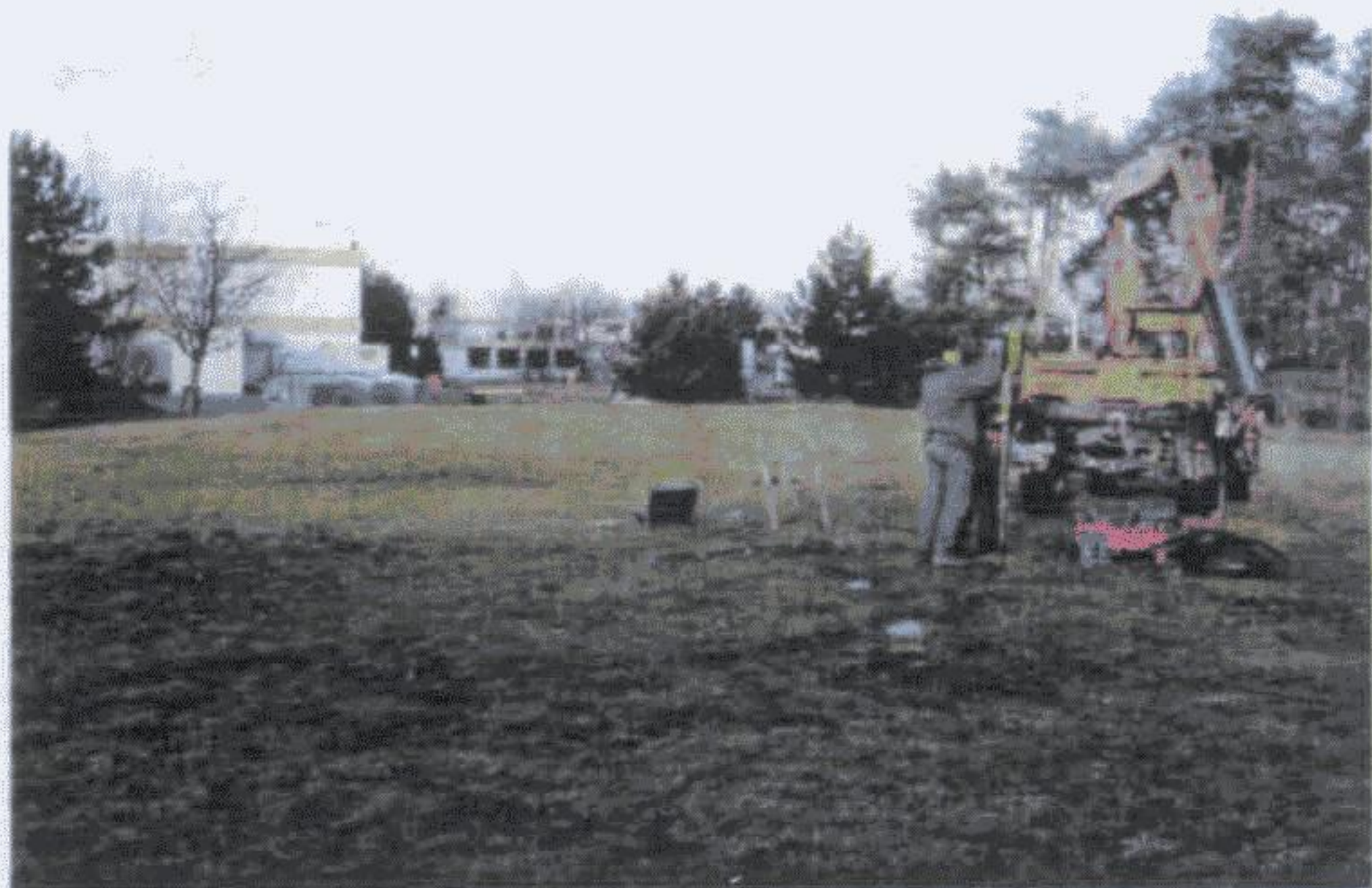
Bild 1: Durchführung der Rammkernsondierung S4
